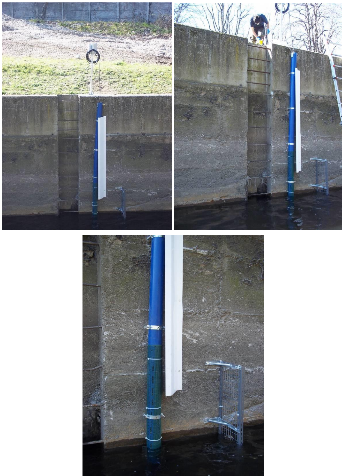
Figura 30 – Installazione della sonda S/N 13M101703 all'interno del T. Seveso
